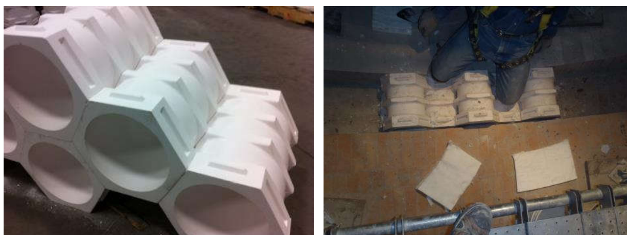
图 6 孟莫克® HexWall™ 六边形陶瓷挡墙安装图，嵌入炉衬（如左图）以及使用榫卯设计进行堆叠、无需耐火泥（如右图）
