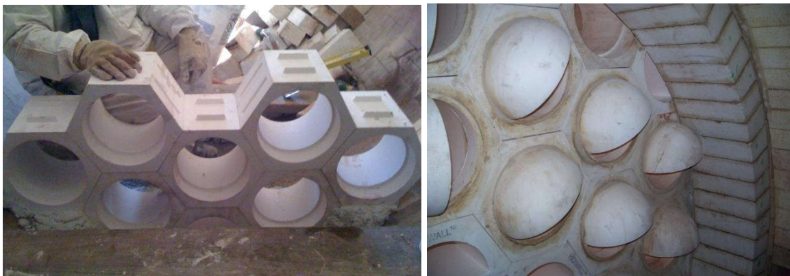
图 1 孟莫克® VectorWall™陶瓷挡墙由六边形砌块堆叠而成，无需耐火泥，六个面全部受到支撑（左图所示）。导流帽能够与每个六边形砌块融为一体，在炉内形成定制的流型（右图所示）。
