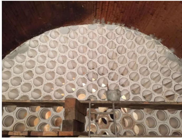
图 4 最近安装的 VectorWall™陶瓷挡墙，它能实现停留时间分布更窄
